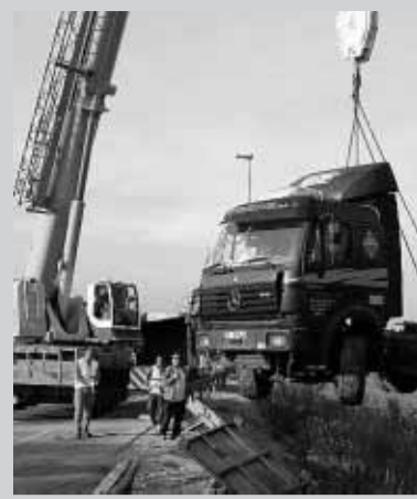
Una grúa retira el vehículo
