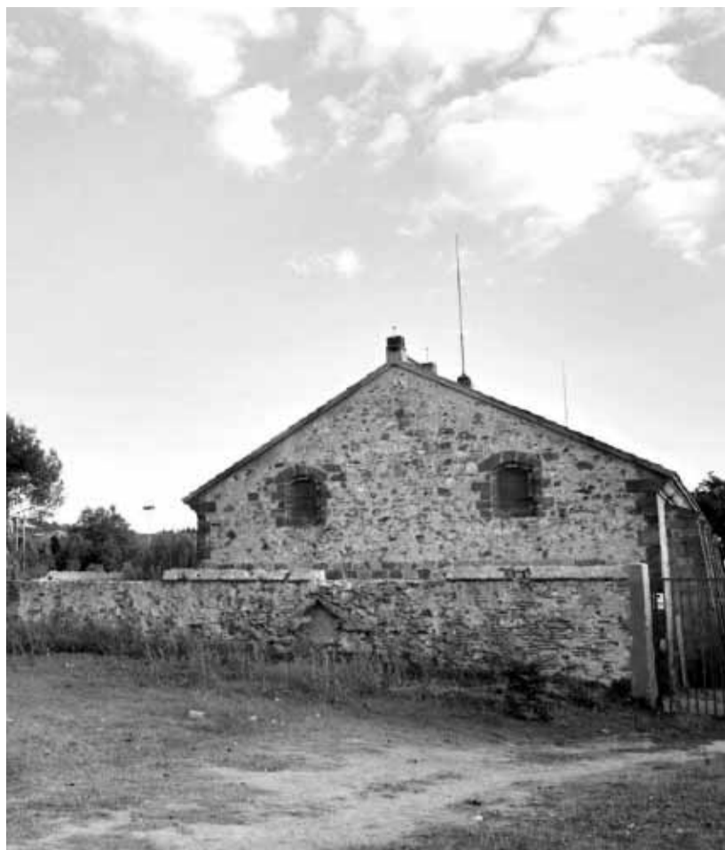
El edificio del Polvorí, una nave de 1.000 m 2 en la falda de Montjuïc
